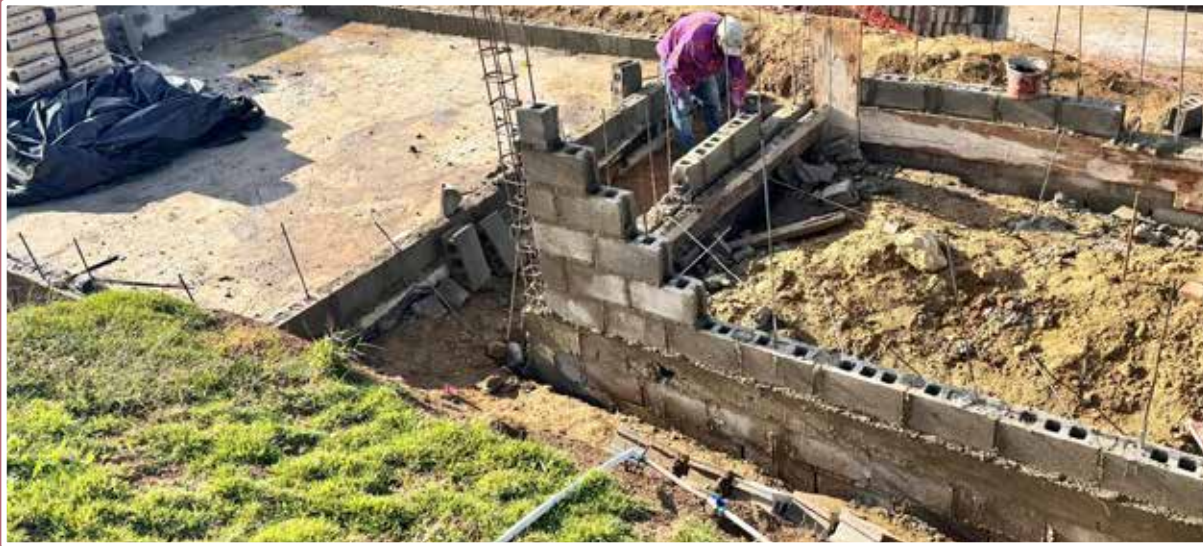
Trabajos en el Monumento a los Héroes de la Restauración.
